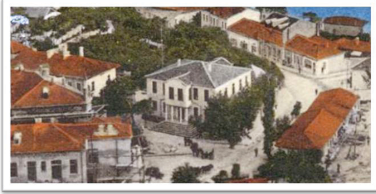
Balçık Belediye Binası
