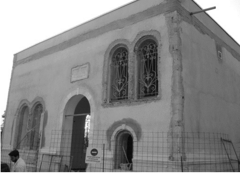
Evrenos Bey Türbesi'nin ön cephesi (Temmuz 2007) Restorasyon yapılırken...
